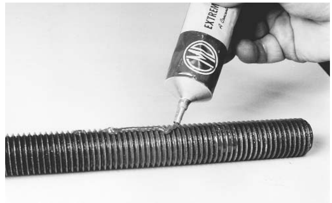
Figura 26. Aplique lubricante al tornillo de cabeza hexagonal
